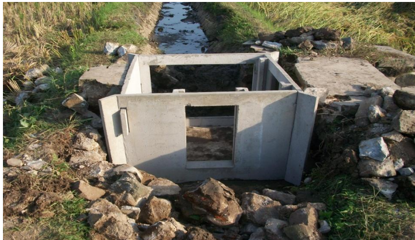
Gambar 5 Bok yang sudah dipasang dan disetel
