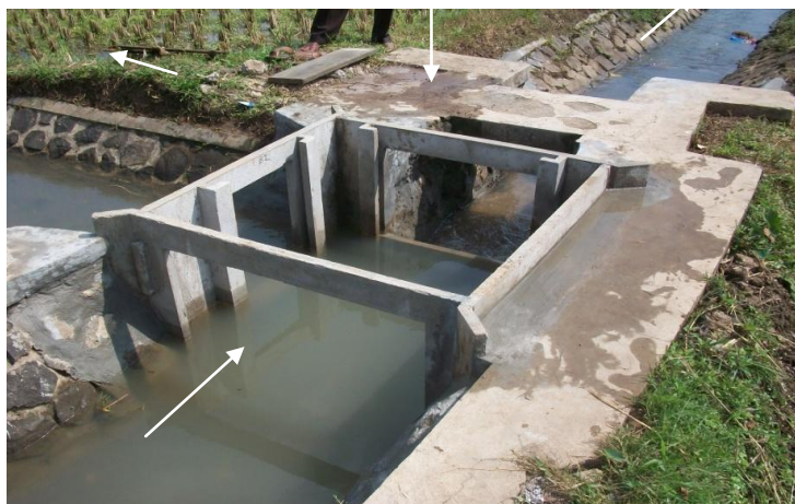
Gambar 7 Box yang sudah dipasang dan sudah beroperasi
