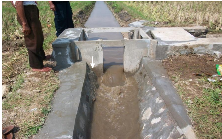
Gambar 6 Bok yang sudah dipasang dan sudah beroperasi
