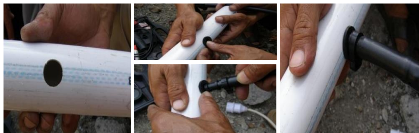
Gambar 8 Sistem Sambungan Pipa Lateral ke Pipa Manifold
