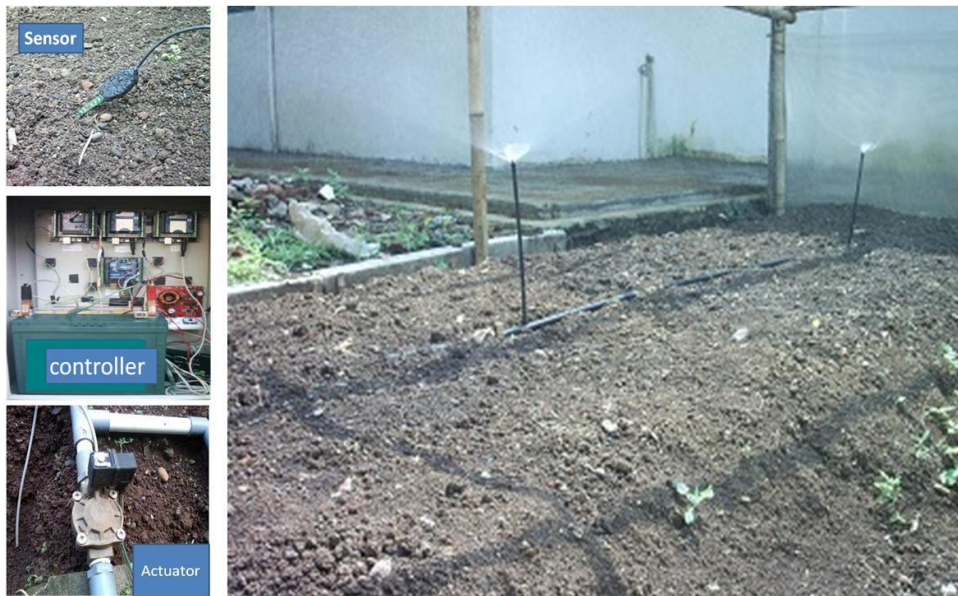
Gambar 5 Sensor, Pengendali, Aktuator dan Sprinkler
